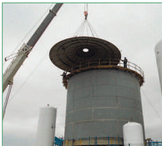
Фото 5. Подъём и установка крыши
